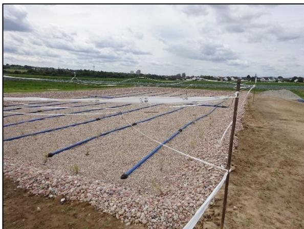
Abb. 12: Pflanzenkläranlage im Aufbau
