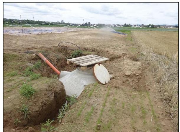
Abb. 13: Pump- und Kontrollschacht der Pflanzenkläranlage
