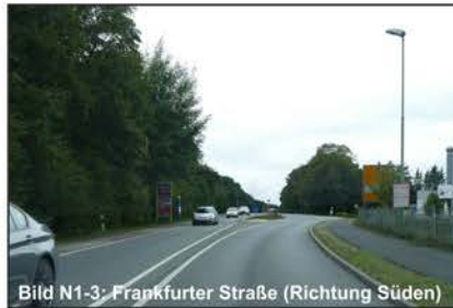
Bild N1-3: Frankfurter Straße (Richtung Süden)
