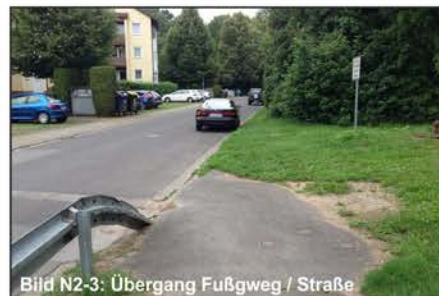
Bild N2-3: Übergang Fußweg / Straße
