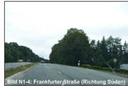
Bild N1-4: Frankfurter Straße (Richtung Süden)
