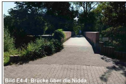
Bild E4-4: Brücke über die Nidda
