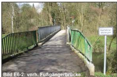
Bild E6-2: vorh. Fußgängerbrücke
