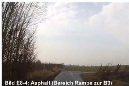
Bild E8-4: Asphalt (Bereich Rampe zur B3)
