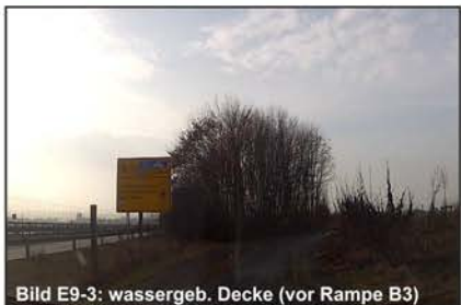
Bild E9-3: wassergeb. Decke (vor Rampe B3)
