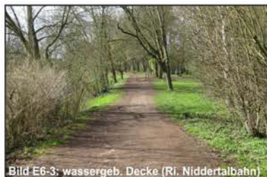
Bild E6-3: wassergeb. Decke (RI, Niddertalbahn)
