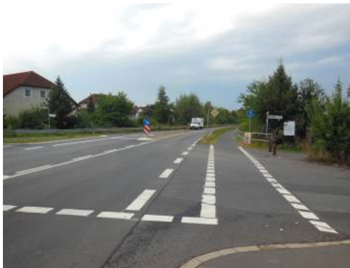
4- Büdinger Straße (L 3008) - Blick nach Westen
