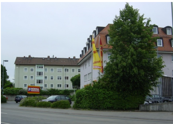
Bild 8: Gebäude Kasseler Straße / Dieselstraße, im Vordergrund Mansarddachform
