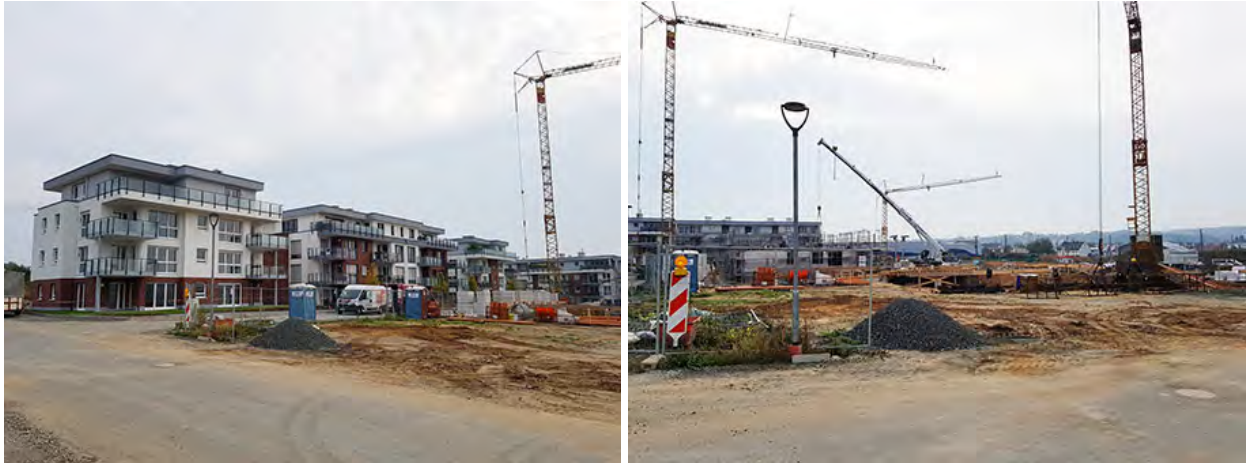
Abbildung 14: In Realisierung befindliche Wohnbebauung des Baugebietes „Im Schleid“
