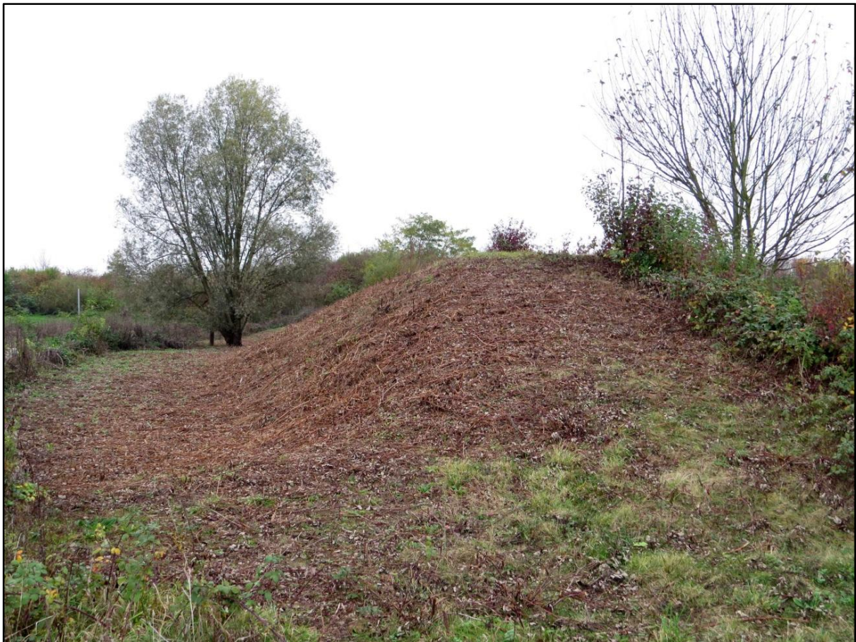
Abb. 2: Der Lärmschutzwall von Osten aus gesehen, 25. Oktober 2017
