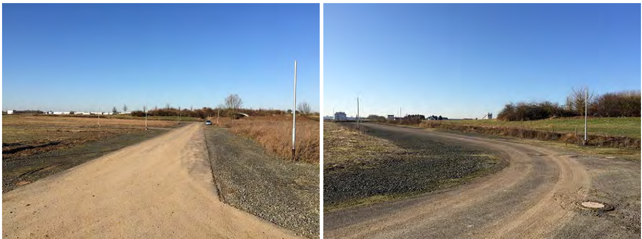
Abbildung 19: Bereits fertig gestellte Erschließungsstraßen im Plangebiet
